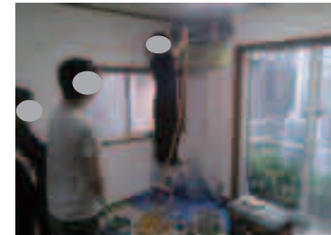
エアコン分解洗浄実技風景
